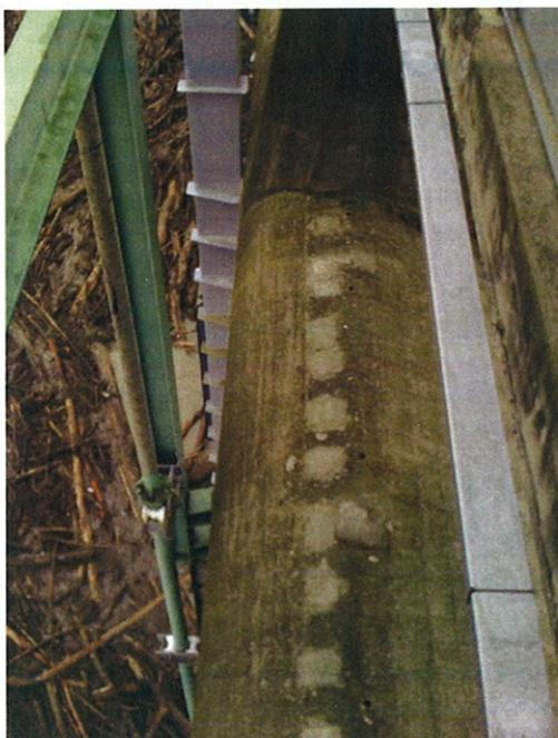
Figura 7 - Particolare del manufatto regolatore della Cassa. Si noti la presenza di materiale flottante che impedisce la movimentazione delle paratoie che regolano i volumi in transito nelle luci di fondo
