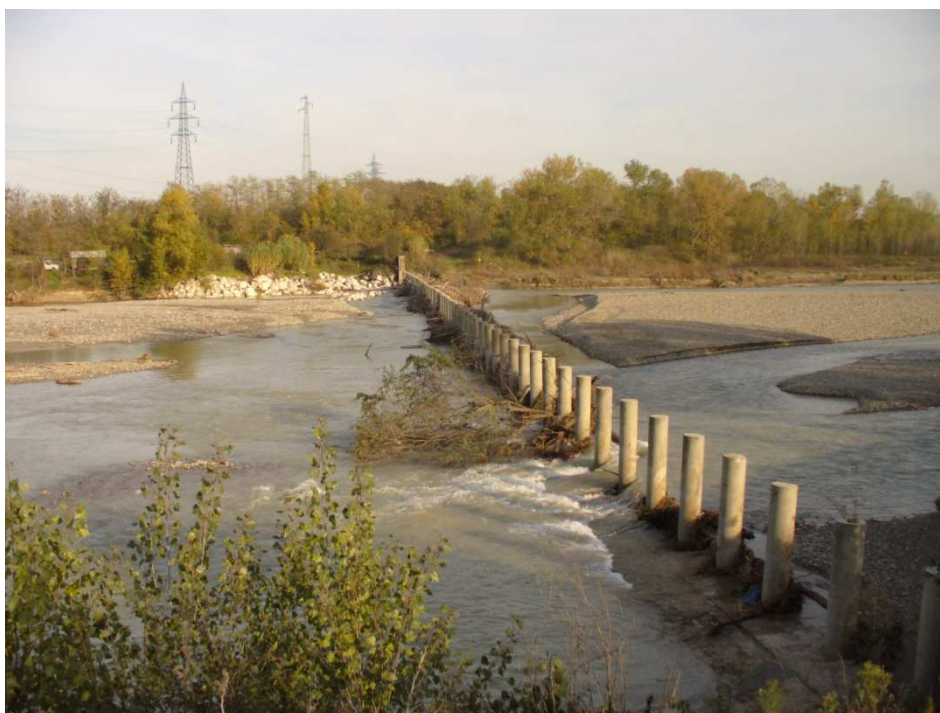
Figura 3 - Briglia a pettine con funzione di trattenuta del materiale flottante
