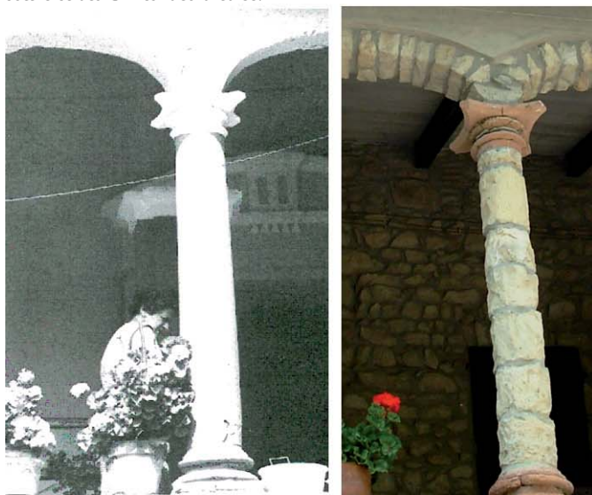
Figg. 58-59: No. Intervento incongruo di rimozione dell'intonaco che cancella una scelta stilistica storica, mette in evidenza i difetti costruttivi della colonna e le sottrae un elemento di protezione dagli agenti atmosferici.
