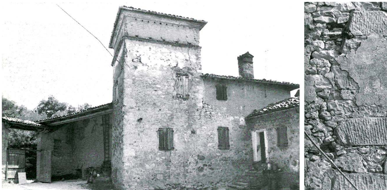
Figg. 56-57: Casa con torre colombaia in cui si conservano le finiture storiche delle pareti. Dettaglio dell'apparecchio murario protetto da un sottile strato di intonaco a calce.
