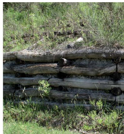
Fig. 103: Sì. Struttura lignea che impedisce lo smottamento del terreno sulla strada.
