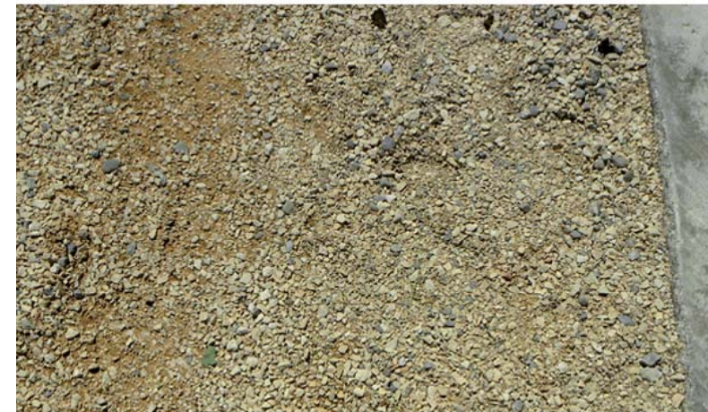
Fig. 114: Sì. Pavimentazione con ghiaia fine su battuto di terra.
