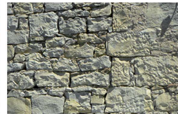
Fig. 48: Dettaglio di una muratura a filaretto con i cunei per il serraggio dei conci.
