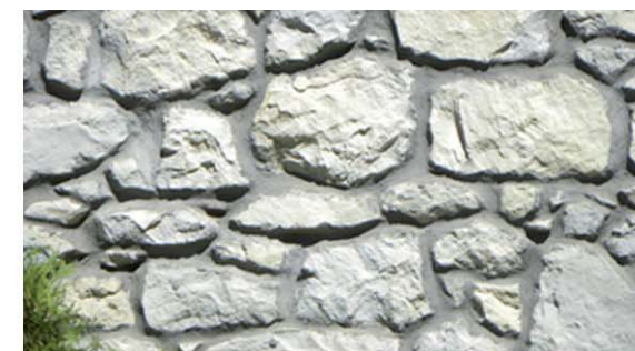
Fig. 47: Impiego improprio di malte cementizie.
