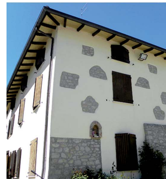
Fig. 60: No. Finiture da evitare: intonaco inframmezzato da brecce a faccia vista.
