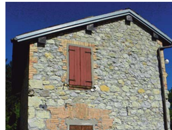
Fig. 45: Impiego improprio di malte cementizie.
