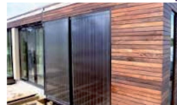
Fig. 125: Sì. Una pellicola fotovoltaica integrata in un'apertura verticale.
