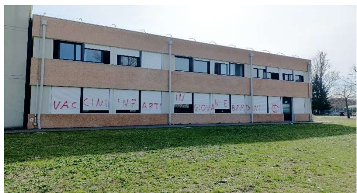
PARETE 2 ISTITUTO CORNI
