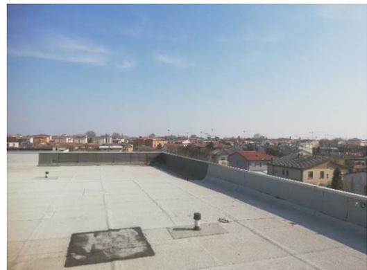
Oltre al ghiaione, al fine di agevolare il passaggio in copertura ai fini manutentivi, si prevede altresì l'individuazione di percorsi realizzati mediante l'installazione di quadrotti prefabbricati in graniglia alloggiati su supporti plastici.
