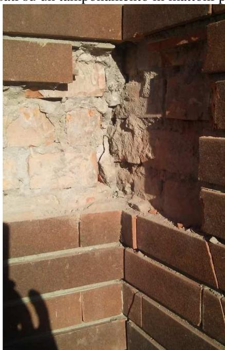
Il saggio effettuato sulla facciata D1 zona d16, aveva evidenziato anch'esso il distacco del rivestimento dalla struttura in c.a. che però non ha rivelato ammaloramenti del c.a..
