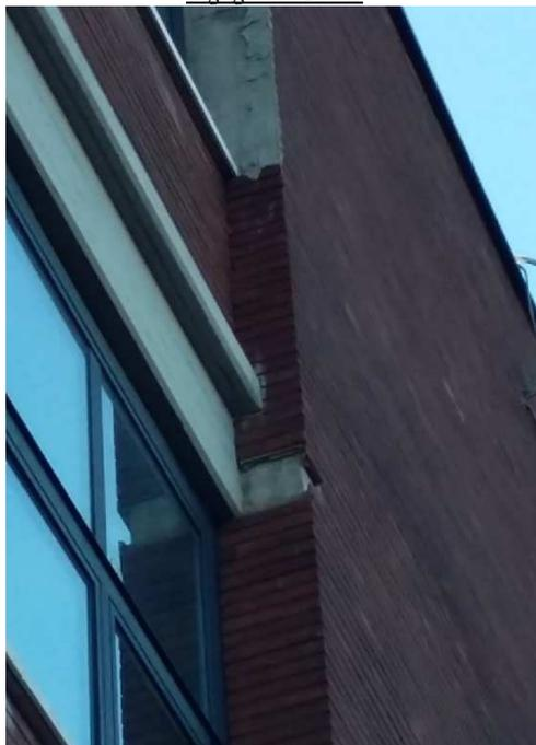
Nella zona d19 si è effettuata una battitura che ha evidenziato un rumore da distacco del rivestimento, si è preferito non effettuare un saggio distruttivo per non causare il distacco di una più ampia zona di rivestimento. Il rivestimento in laterizio è presente negli edifici A, B, C, D, E, G.
