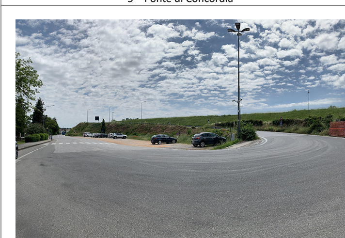
6 – Accesso al ponte di Concordia e all'argine del Fiume Secchia
