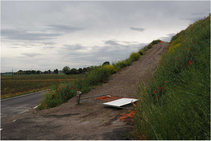
2 – Accesso alla sommità arginale Fiume Secchia
