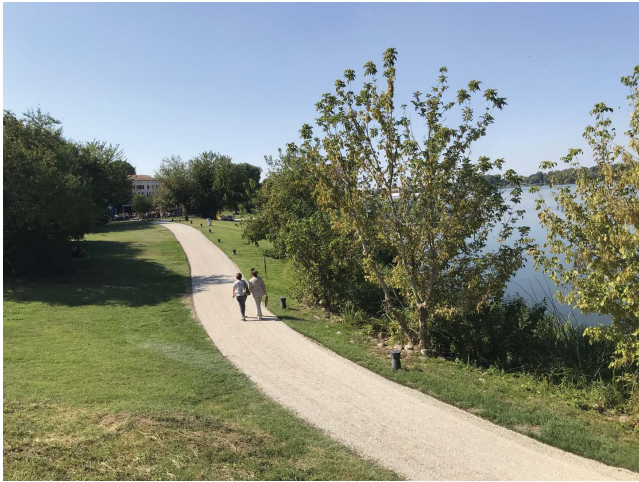
Esempio di realizzazione in emulsione bituminosa triplo strato
