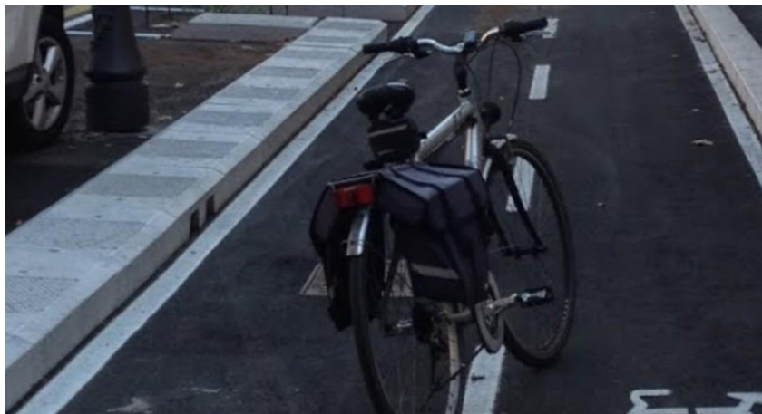
Figura 36 Esempio di cordolo separatore in calcestruzzo prefabbricato
