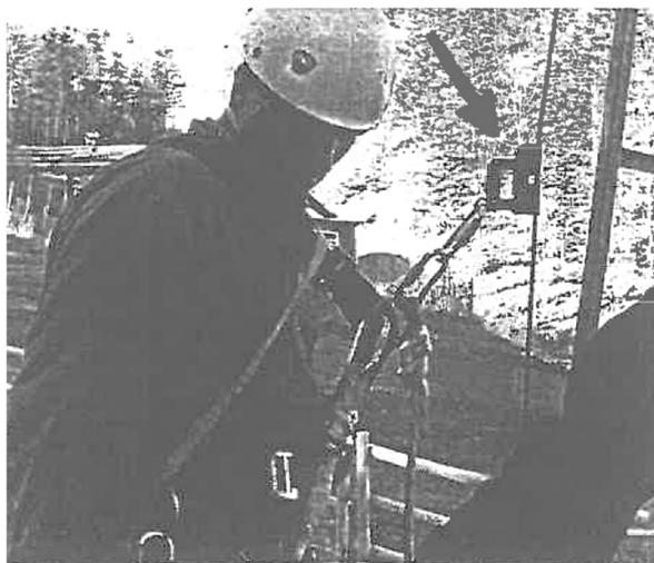
Prima di salire sulla scala bisogna accertarsi dell'efficienza del dispositivo anticaduta (integrità del cordino in acciaio e corretto montaggio della pinza collegata all'imbracatura).
